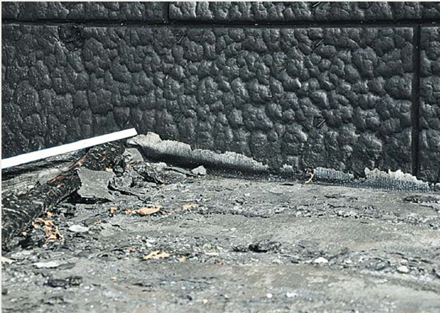
Die Situation des Übergangs vom Dach zur aufgehenden Fassade. Deutlich erkennbar die verkohlten Reste der glasvliesverstärkten bituminösen Dachbahn.
