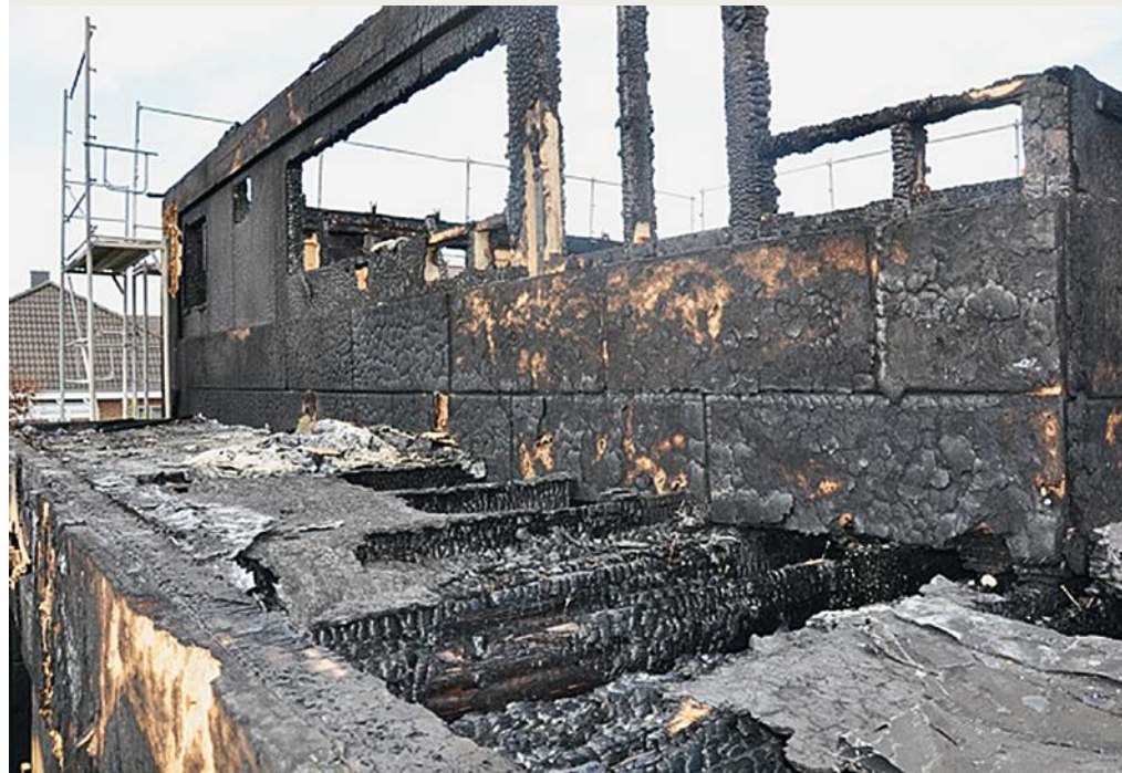
Die Holzständerbauweise und eine im Bau befindliche Holzfaser-Dämmfassade boten den Flammen ausreichend Nahrung. Nachbarn hörten in der Nacht einen „lauten Knall“.
